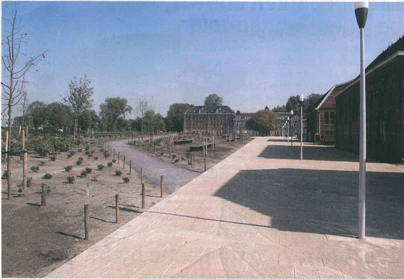
De Westergasfabriek in Amsterdam verwerkte bijna 70 jaar lang, tot 1960, steenkolen voor de productie van gas. Stadsdeel Westerpark besloot het gebied eind jaren '90 te transformeren tot cultureel park. Markus realiseerde de sloop en het hergebruik van funderingen en gewelven, de sanering van verontreinigde grond en slib en een park met duizenden bomen, hagen en planten. Het bedrijf legde paden van sierbestrating en halfverharding aan, evenals een recreatieve weide, sportvelden en een recreatievijver met betonnen randafwerking en watercirculatiesysteem.
